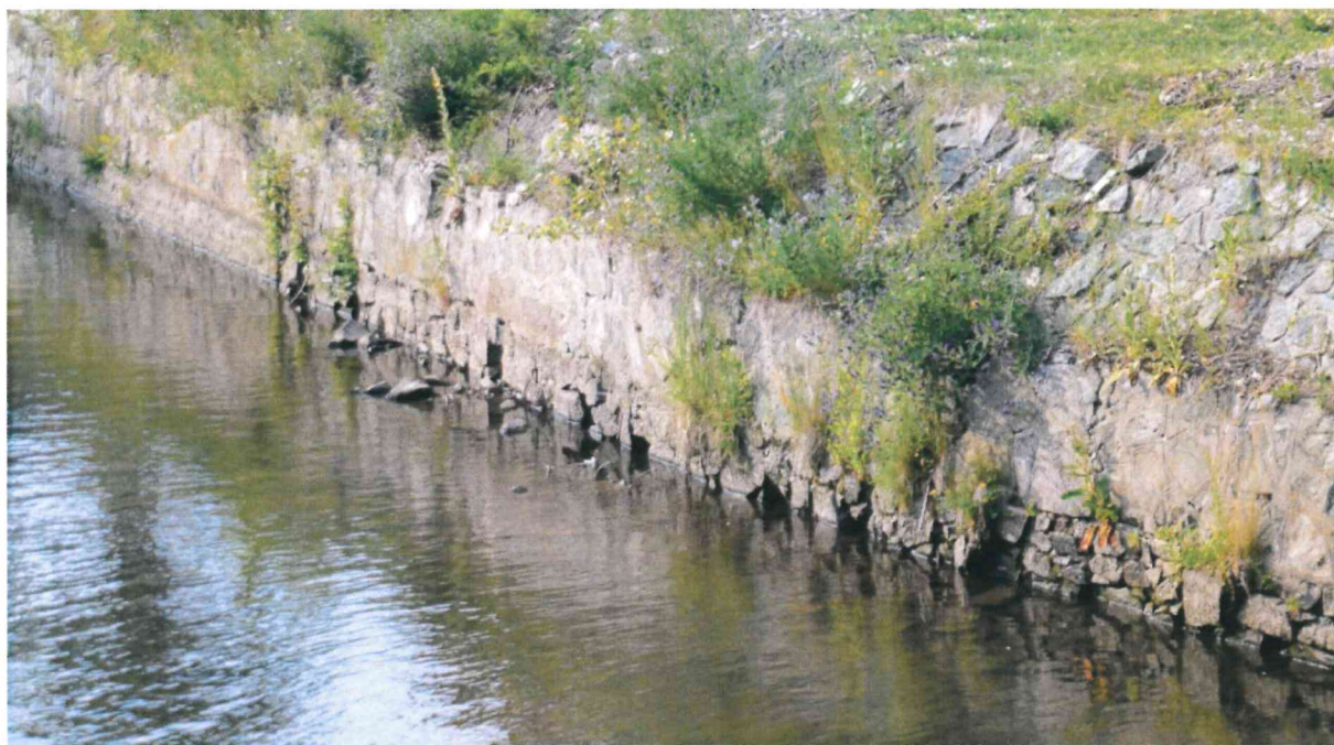
Levá břehová opěrná zeď v podjezí, kamenná část – pohled
