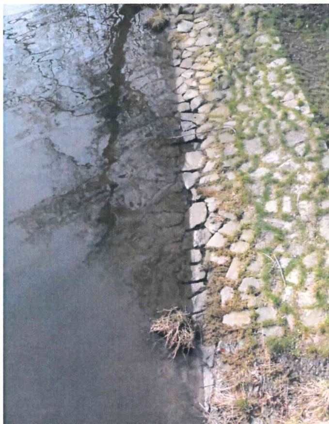
Opevnění pravobřežní části v podjezí, kamenná dlažba – pohled
